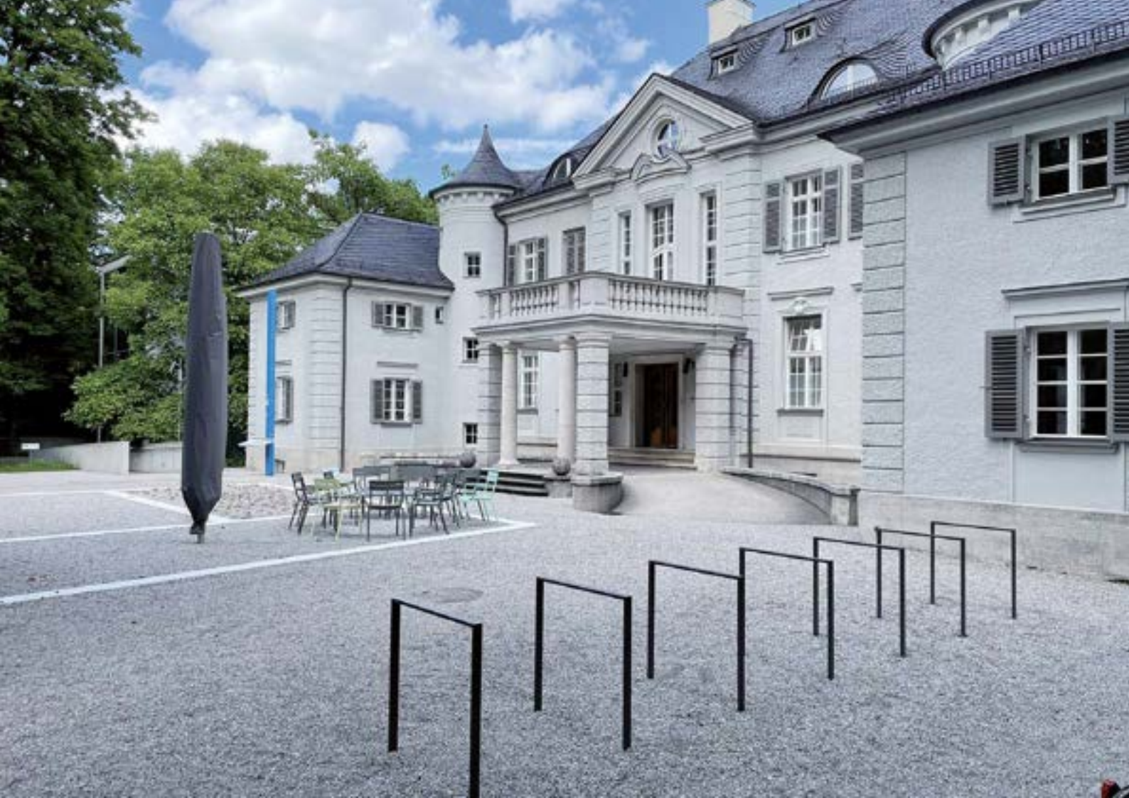
Littmann-Bau, mit neuen Außenanlagen
