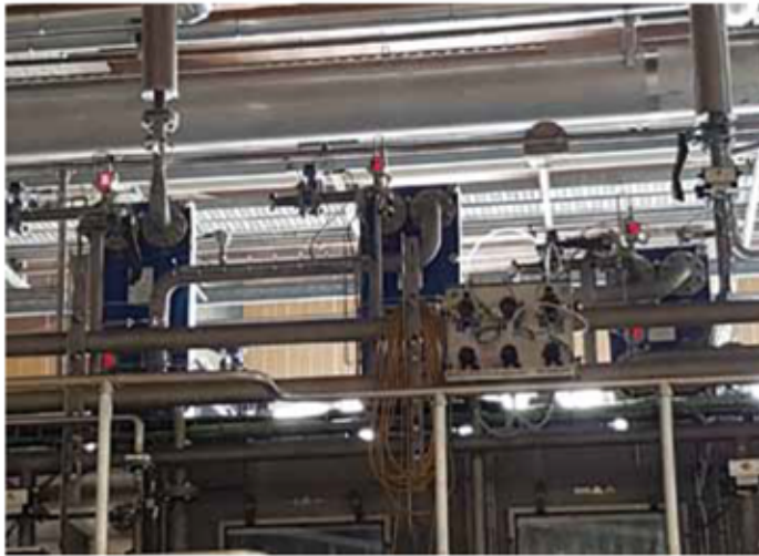
Abb. 2 Kühlung Nachbehandlungszonen (während Montage)
